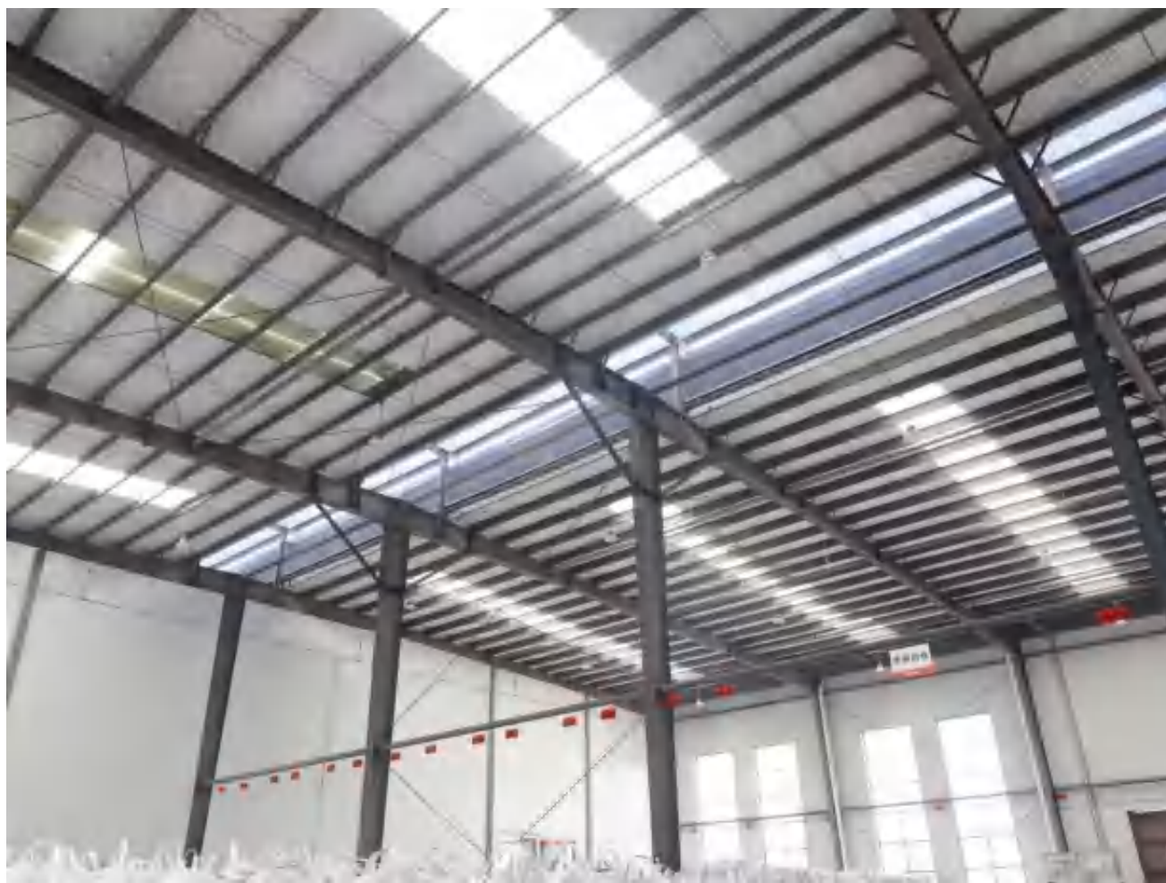
附件 1-6-1 钢结构厂房照片
