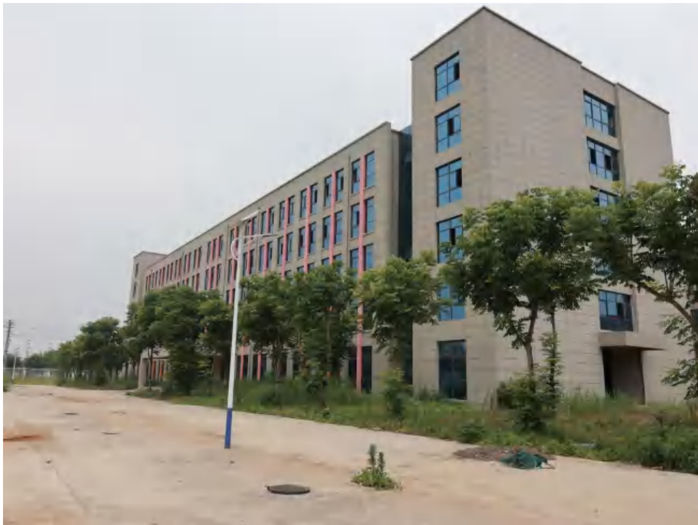
附件 1-6-2 混凝土结构办公楼照片
