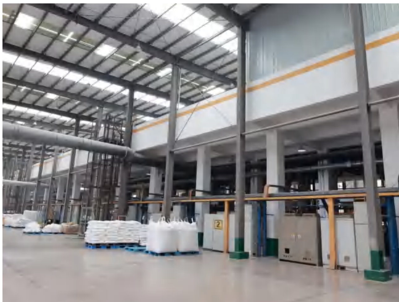
附件 1-9 生产厂房多层建筑照片
