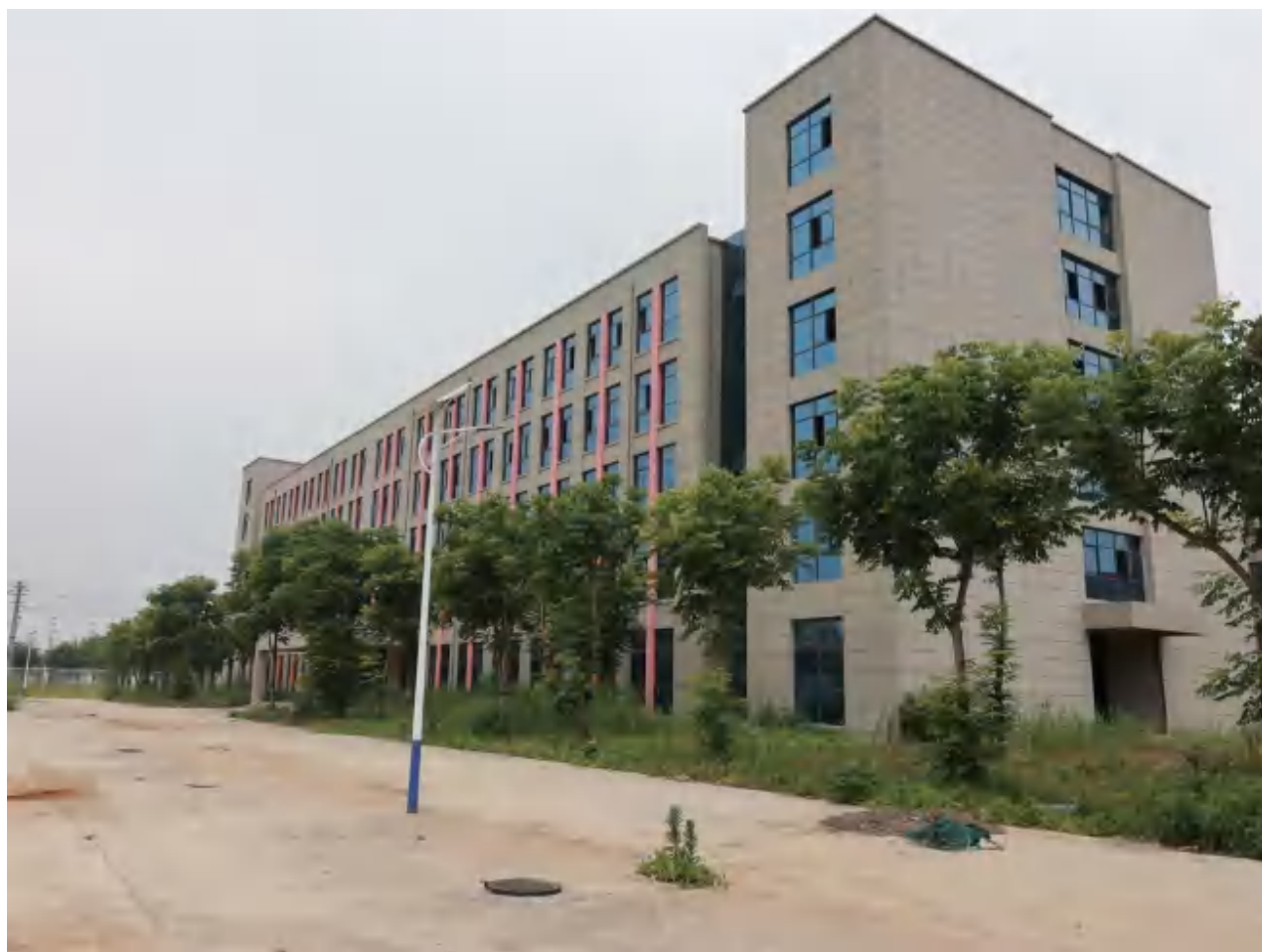
附件 1-7-1 厂区绿化照片
