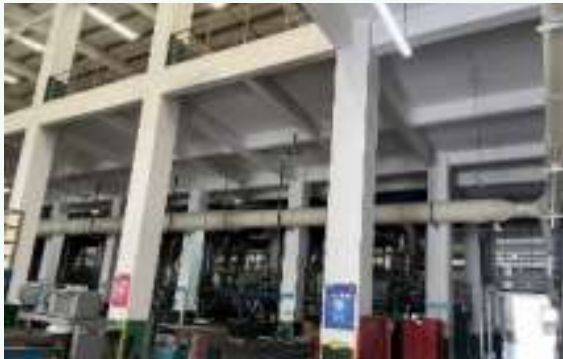
改造后：管道更换，收集风速已达标
